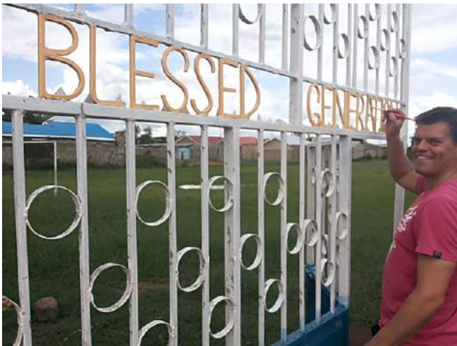
Jaap Kingma, voorzitter van de Stichting Geen Dak werkt aan het toegangshek van BG High
